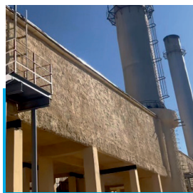
ТЭЦ-1: новые газоходы
